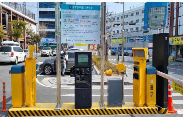
통제영주차장 옥외 출구 무인정산기 설치
