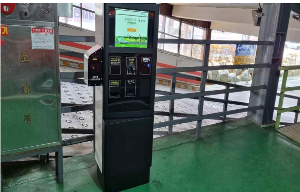
통제영주차장 2층 무인정산기 설치
