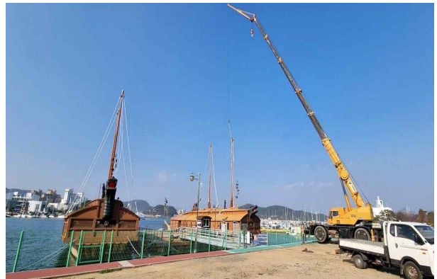
전좌거북선 새 돛대 설치 작업
