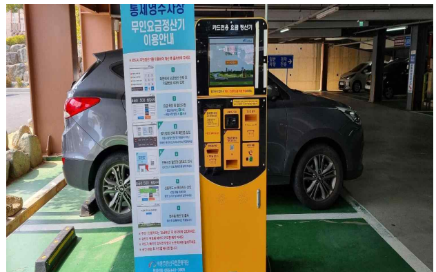
통제영주차장 옥내 무인정산기 설치
