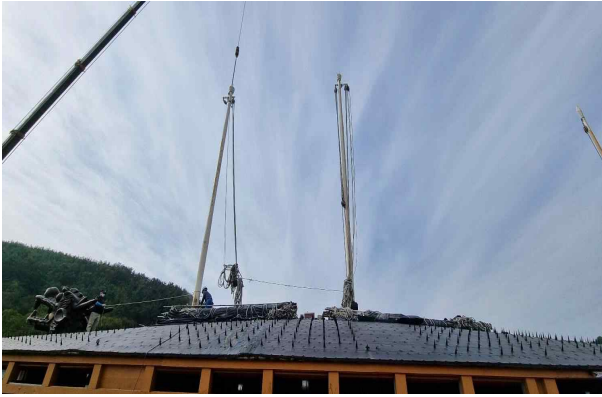
거북선 기존 돛대 철거 작업
